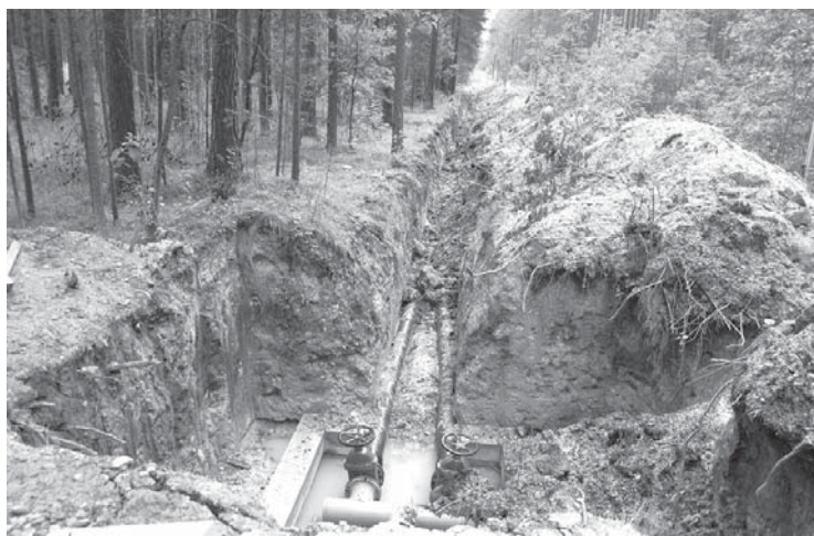
Прокладывается новый водовод
