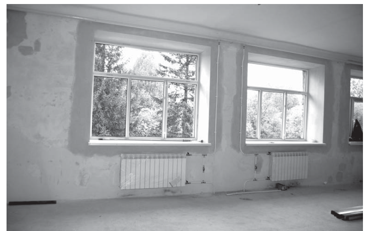
В садике «Лесная сказка» кипит работа - внутри отштукатурено, подведено тепло, заменена электропроводка, старые окна меняются на пластиковые
