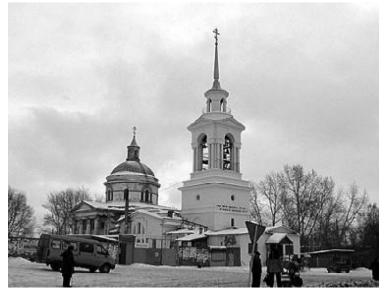
Церковь после реконструкции
