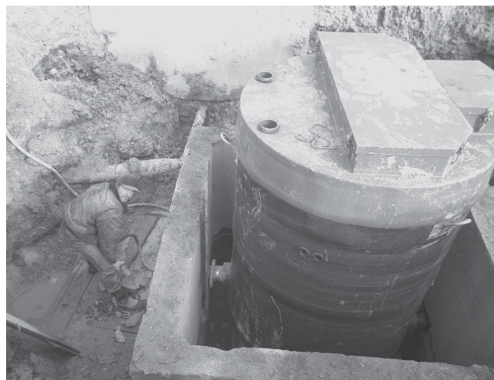
НА СНИМКЕ: идет монтаж КНС.
